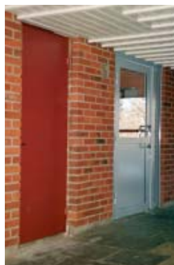
Brandparti EI 30 tillverkat i Sapa byggsystem. Levererat till Skanstulls gymnasium.
